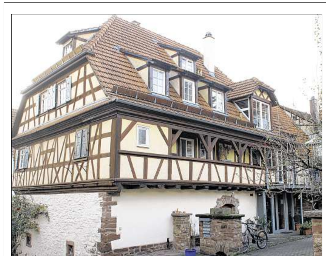
ORTSBILDPRÄGEND: Eines der denkmalgeschützten Gebäude an der Hauptstraße. Foto: wg
