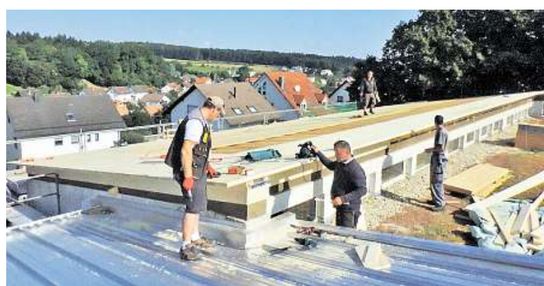
Baustelle mit Aussicht: Das Dach der Grundschule in Mutschelbach wird saniert, ebenso wie die Grundschulen in Auerbach und Ittersbach. FOTO: WEBER
