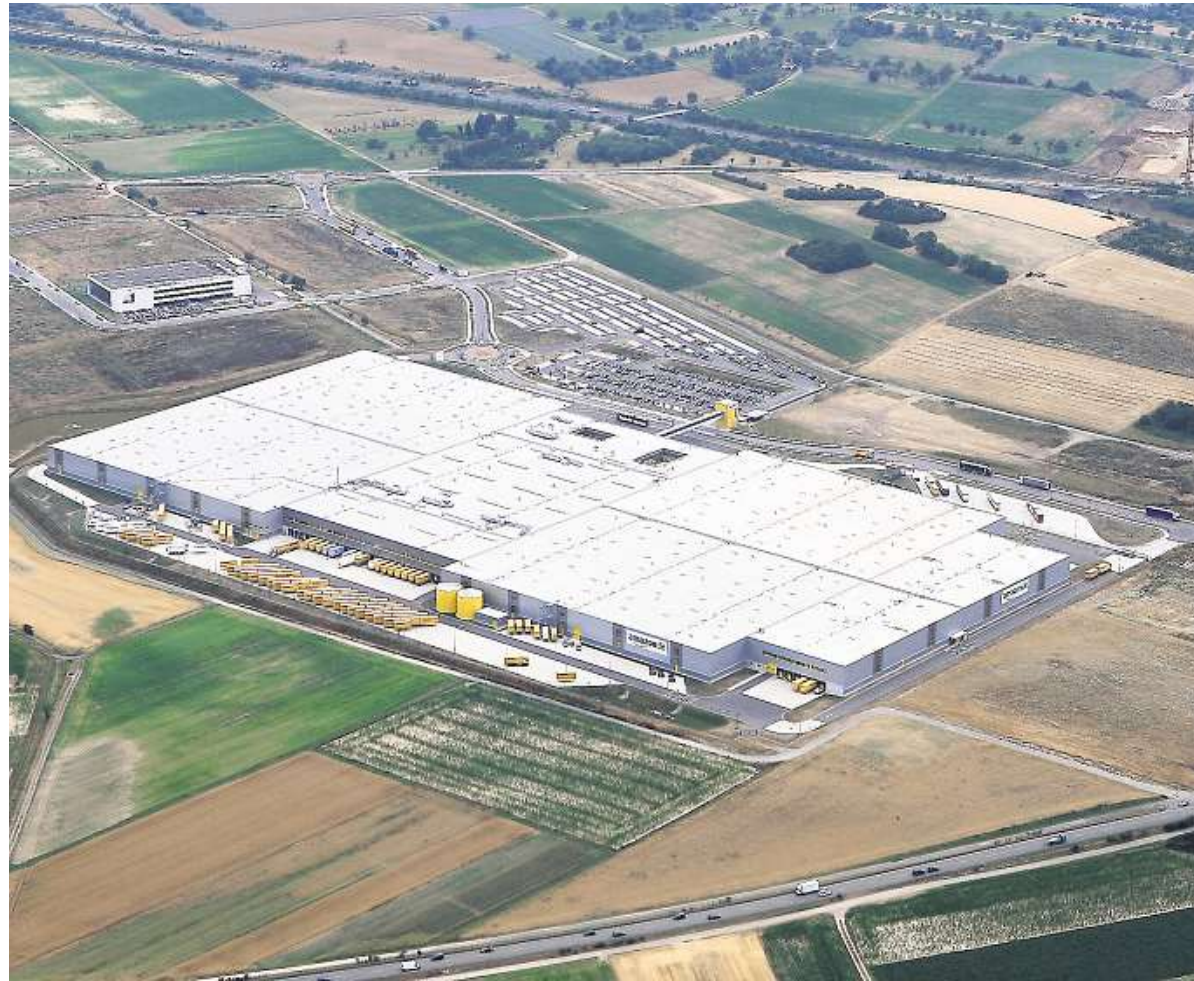
Der Flächenverbrauch beschäftigte gestern den Planungsausschuss des Regionalverbands in Mühlacker. Dabei wurde auch das Amazon-Logistikzentrum in Pforzheim angesprochen. Das Luftbild entstand im August dieses Jahres. FOTO: KETTERL
