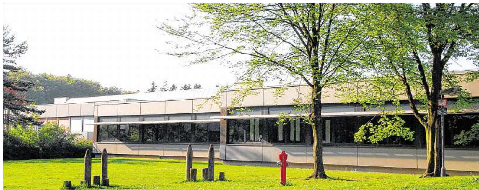
IM BISHERIGEN GRUNDSCHULTRAKT der Otto-Riehm-Schule will Ispringen die erste kommunale Kinderbetreuungsgruppe in der Gemeinde für Drei- bis Sechsjährige einrichten. Foto: Manfred Schott
